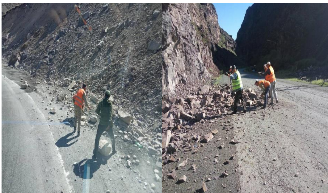
Очистка дорог от мусора и камнепадов
