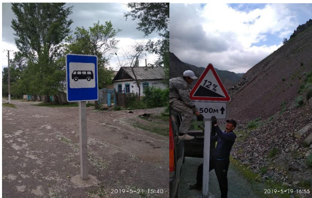
Установка дорожных знаков
