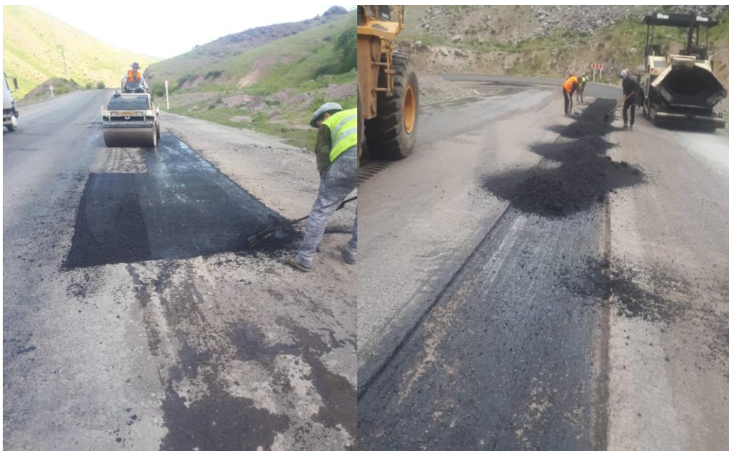
Текущий ремонт дорожной одежды
